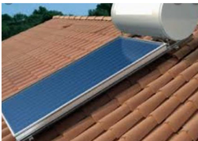
Referencia colector solar térmico par ACS.
